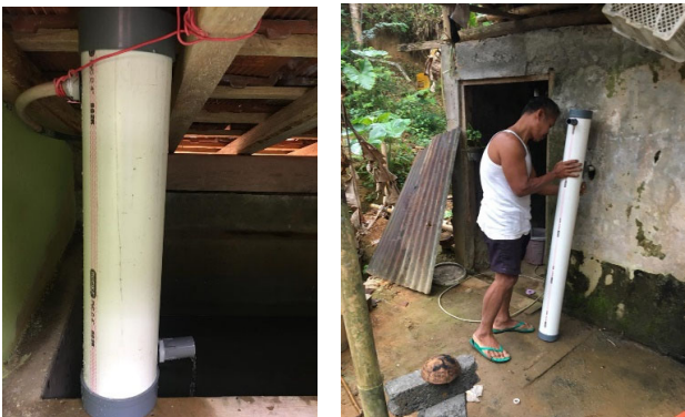
Gambar 3 (kiri) Pemasangan Filter air di masjid Babul Jannah. Gambar 4 (kanan) Pemasangan filter air di salah satu rumah warga.
